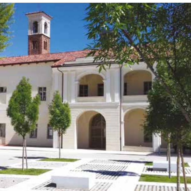
Il complesso dell'ex monastero di San Pietro Martire, collocazione degli uffici Univer
